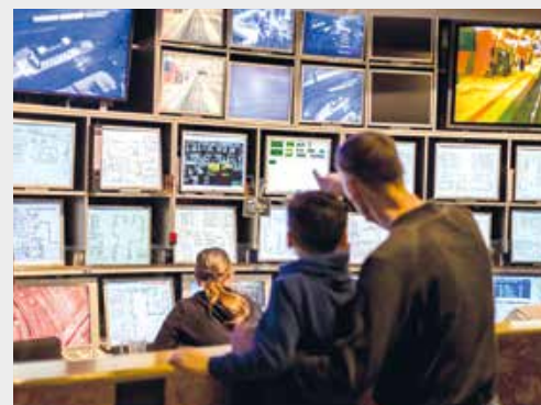
◀ control center | Schaltzentrale
