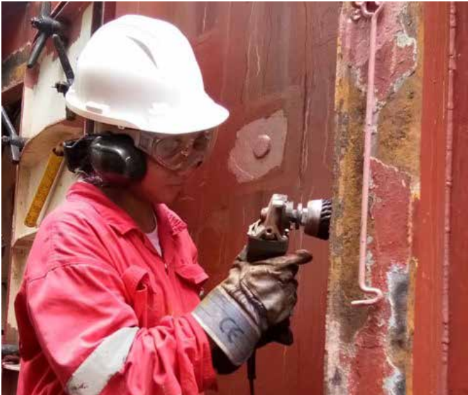
🔧 Surface preparation for painting | Oberflächenvorbereitung zum Malen
